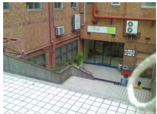
本館地下「キュア」入口階段
